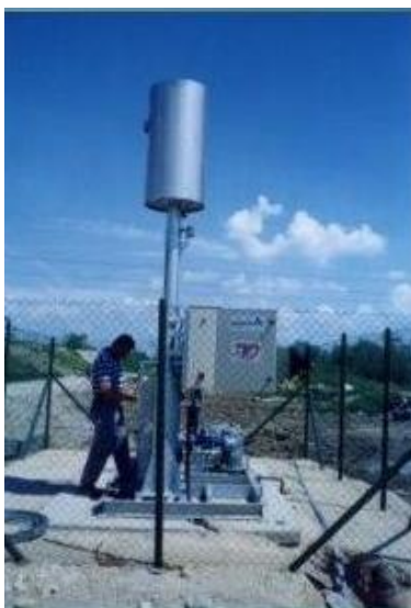
SLIKA 6: NABAVA I MONTAŽA PLINSKO CRPNE STANICE S BAKLJOM
