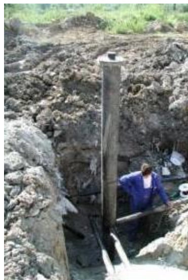
SLIKA 7: RADOVI NA OTPLINJAVANJU
